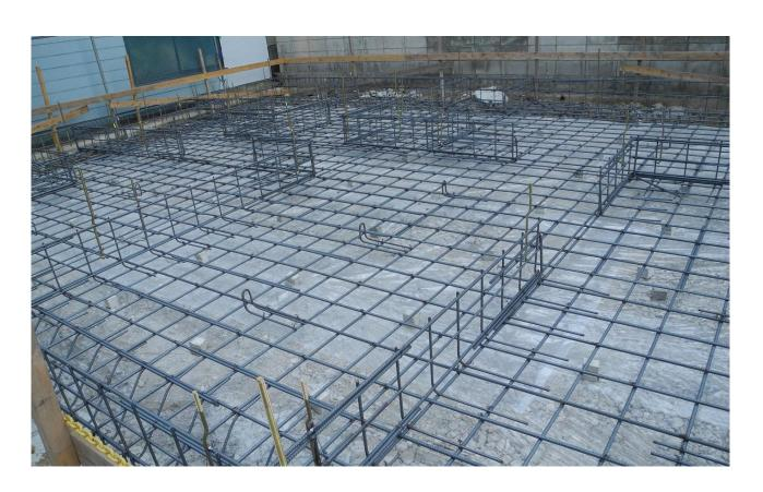
「ベタ基礎」や「布基礎」など住宅の基礎の構造には複数の種類があり、構造によって耐震性能は変わります。一般にはベタ基礎が優れているといわれています。
